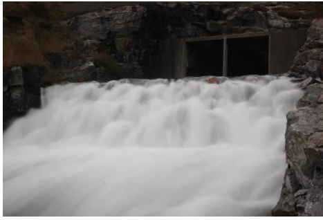
Step 4, Overtopping 0,5 m
