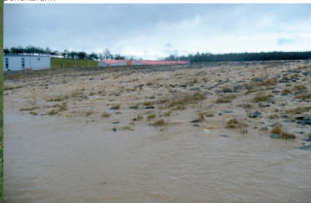
Abb. 4.29: HRB A21, überströmter Damm, Aglasterhausen
