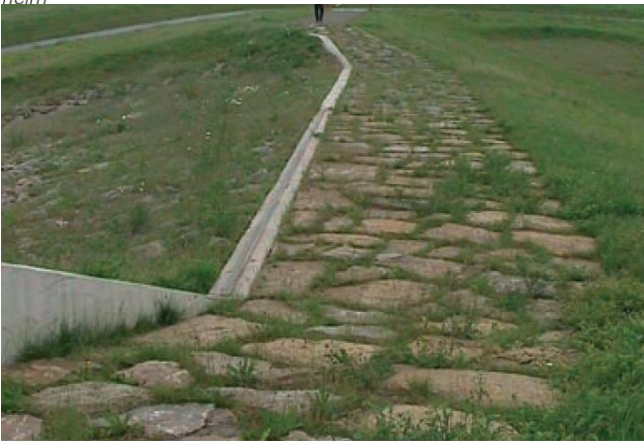
Abb. 4.26: HRB Gewesterbach, abgesenkter Überlaufbereich, Buchen
