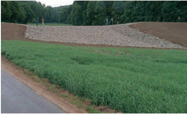
Abb. 4.27: HRB Binsenklinge, Dammscharte (kurz nach dem Bau), Sinsheim
