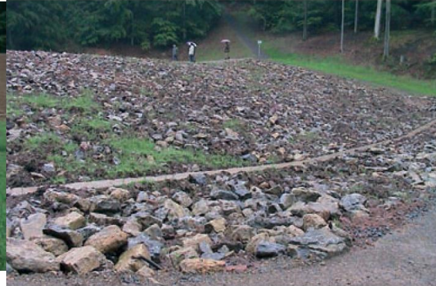
Abb. 4.28: HRB Haager Tal, überströmbarer Damm (Steinschüttung), Schönbrunn
